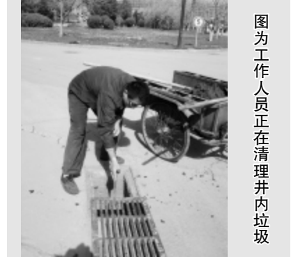
图为工作人员正在清理井内垃圾
