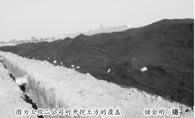
图为工程二公司对开挖土方覆盖。 储会刚/摄
