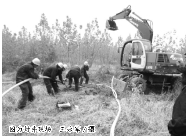
图为封井现场 王永军/摄
