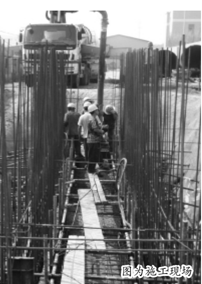
图为建设现场
