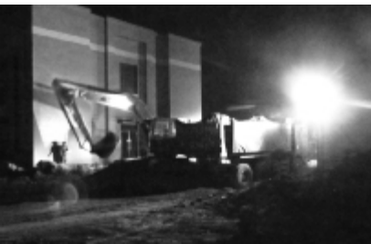
图为工作人员在夜间紧张施工
