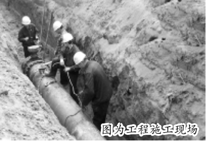
图为工程施工现场
