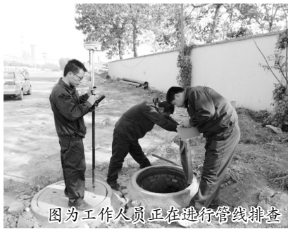
图为工作人员正在进行管线排查
