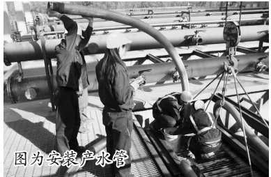
图为安装产水管
