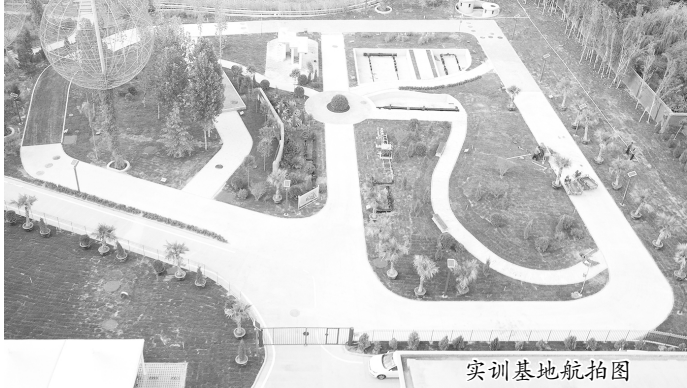
实训基地航拍图
