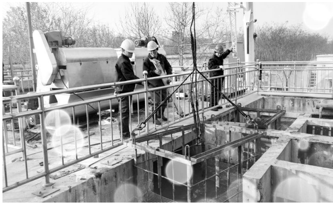
由于污水处理厂进水中细小杂质过多,严重影响后续设备工艺处理。污水处理厂设备科协同汇基公司相关人员,积极想办法找对策,最终决定在2组细格栅出水渠后分别加装了一套滤网装置。经过一段时间运行,效果非常显著,不仅截留了大量的杂质,大大减轻了阶梯格栅、转鼓格栅的压力,而且对减轻MBR膜系统堵塞也起到了一定的作用。
