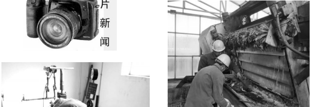
污水中常常携带着大量的泥沙、垃圾、棉絮、毛发等杂物,是污水处理中很头疼的问题,这些杂物附着、侵蚀、缠绕、堵塞运行中的各种设备,加快设备磨损、使设备效率降低,增加了维保频次及维修难度。为做到防患于未然,11月初,工程二公司维保人员不辞辛苦,进行了每季度一次的定期运行设备清理、保养工作,努力保障其正常运行。图为维保人员正在清理阶梯网栅中的浮渣及缠绕异物。
