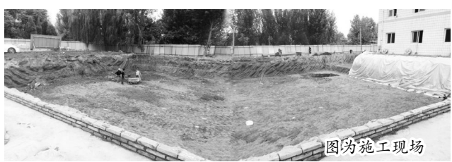
图为施工现场
