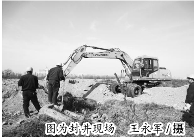
图为封井现场 王永军/摄
