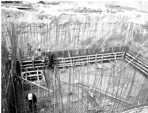
图为施工人员正在进行模板安装
