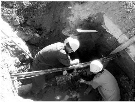
图为施工人员正在进行管道勾头施工
