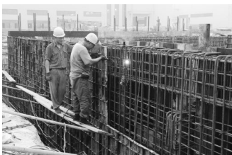
1800 立方米水池钢筋绑扎现场
