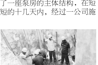
进水闸门井钢筋绑扎
