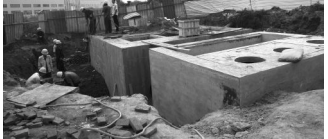
苍山街临时污水泵站已完成的主体
