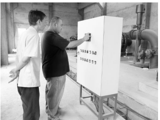
图为鼓风机调试现场
