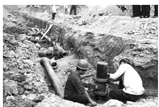
格力配套产业园生活区管道铺设
