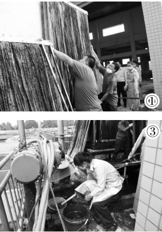
①洗膜小组长张海波和米壮正在拆卸膜组件 ②冲洗膜丝表面的附着物 ③捞取冲洗下来的棉丝等杂物
