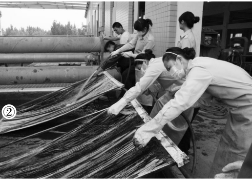
①洗膜小组长张海波和米壮正在拆卸膜组件 ②冲洗膜丝表面的附着物 ③捞取冲洗下来的棉丝等杂物
