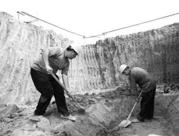
施工人员在40立方水池的工作场内开挖集水坑
