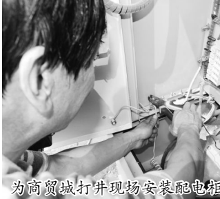
为商贸城打井现场安装配电箱
