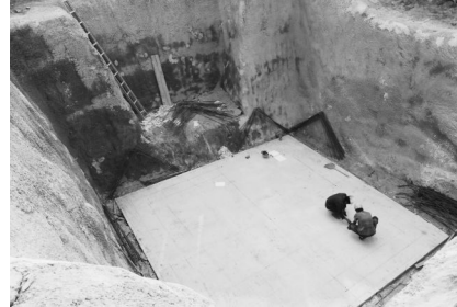
做好垫层的污水提升泵站
