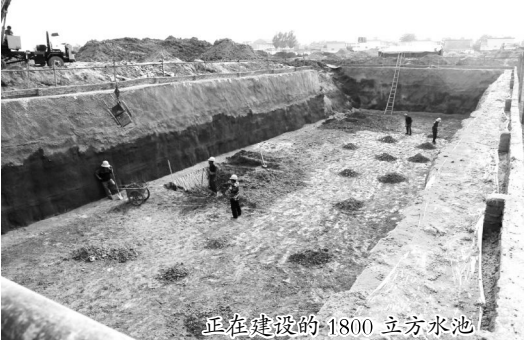
正在建设的1800立方水池
