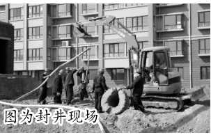
图岗封井现场
