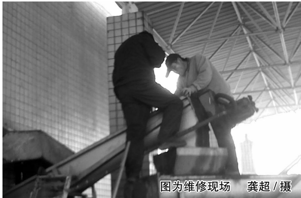
图为维修现场 龚超/摄
